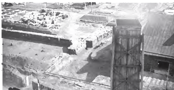
Строительство завода «Коминтерн»
